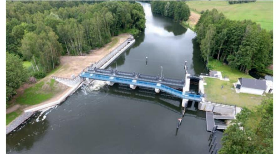
Das neue Wehr mit Fischaufstieg, Kahnschleuse und Überquerung für Fußgänger und Radfahrer
