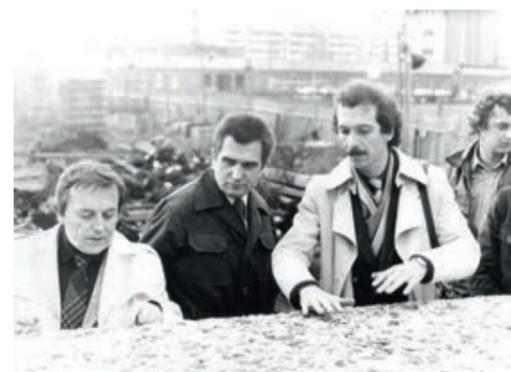
Die Kieselsteine für die Waschbeton-Fassadenplatten wurden mit der Hand in den frischen Beton gedrückt
